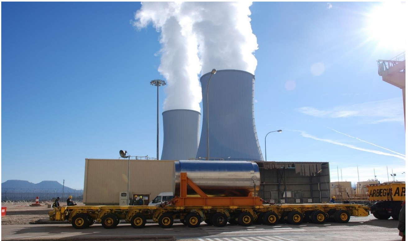
Maniobra transporte contenedor del edificio de contención al ATI
